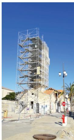
Der Leuchtturm ist im Laufe der Zeit immer mehr verfallen. Daher leitet die Gemeinde „Grau du Roi“ 2016 seine Restaurierung ein. Fundamente, Böden, Fassaden, Balken, Dach, Treppen, Laterne, Leitern... alles wird untersucht und anschließend repariert oder ersetzt!
